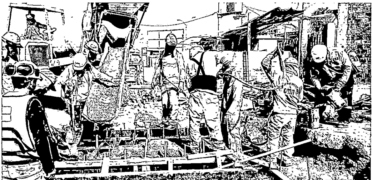
Foto N° 02: Concreto en losas con alveolos CONSORCIO MARITIMO DEL CARIBE - DPA RUCCHO
